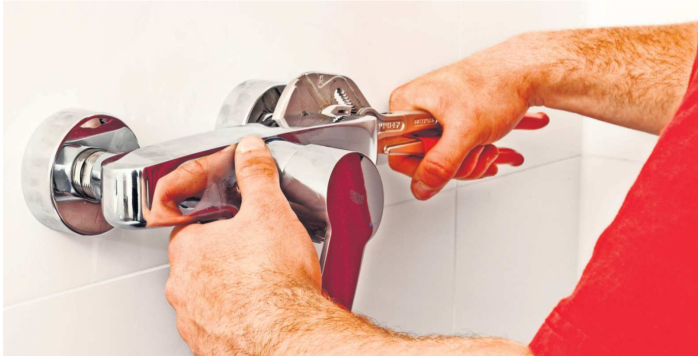
Bei der Sanierung eines Bads können – gerade in Altbauten – rasch mehrere Gewerke gefordert sein. Foto: Marketing Handwerk GmbH
